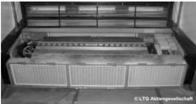
Figuur 7: Inbouw van de decentrale klimaatunit QVM in een borstweringsnis / coördinatie met M+R / Veiligheidstechniek etc
